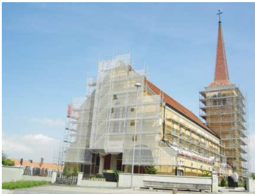
Sous les échafaudages, une patiente restauration s'opère
